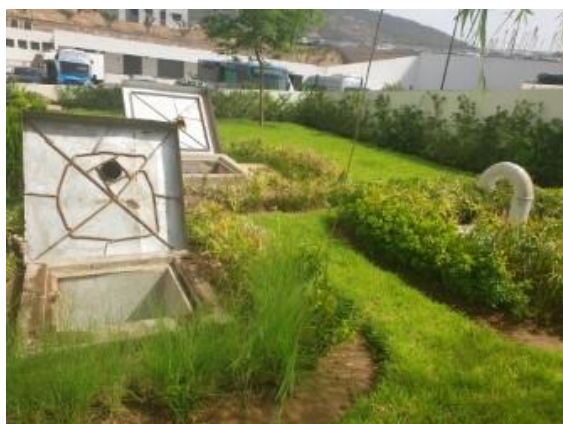
Conservation de l'eau - Réservoir d'eau souterrain (incendie et sanitaire et cascade, Université Euromed de Fès)
